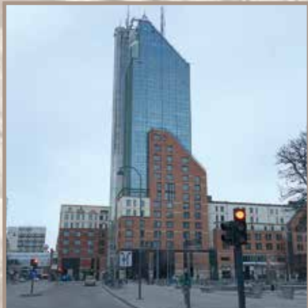
Plaza hotell, i folkmun benämnt "Skrapan". Västerås näst högsta byggnad med 83 m. Högst är Domkyrkan med 102m. VÅRT HOTELL UNDER RIKSTINGET.
